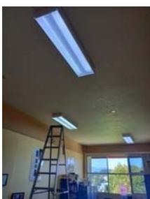
Se reemplazaron las luminarias de gas por lámparas LED, se instalaron sensores de movimiento y se programó el encendido de ciertos bloques de reflectores. Estas medidas lograron reducir el consumo de energía, pasando de 10,338 kWh en diciembre de 2023 a 9,815 kWh en diciembre de 2024.
