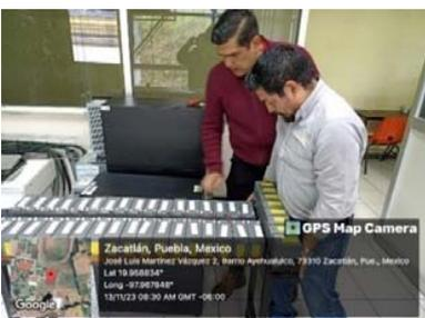
Se realizó la adquisición e instalación de 64 baterías en un UPS (Sistema de alimentación ininterrumpida), con la finalidad de mantener en funcionamiento los diferentes servicios y servidores de la red interna.
